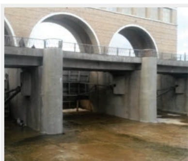
Окончательный вид сооружения после ремонта
